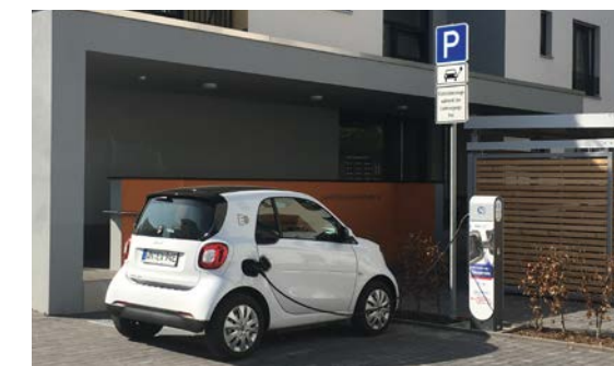
Elektro-Fahrzeuge oder Ladeinfrastruktur: Die Stadtwerke Unna beraten Unternehmen beim Thema Elektromobilität.
