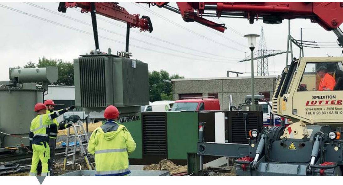
Kontinuierlich investieren wir in das sichere Netz: Hier der Einsatz neuer Trafos im Umspannwerk Unna.
