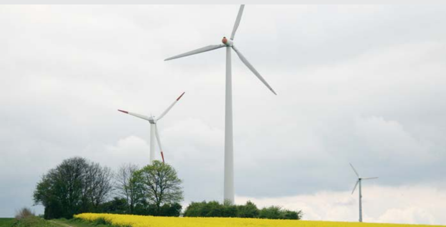
Windkraftwerke am Ostenberg: Ein Bürgerwindrad haben wir 2018 übernommen.
