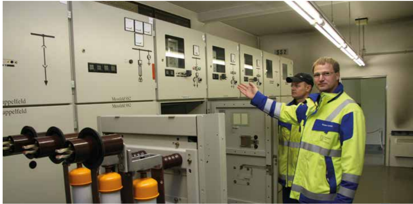
Die Station Kissenkamp (kleines Bild links) wird von unserem 10 kV-Team komplett mit neuer Technik ausgestattet. In der Station Werler Straße werden die großen Leistungsschalter rundum geprüft und überholt. Von beiden Arbeiten merken die Kunden nichts. Die Stromversorgung wird nicht unterbrochen.
