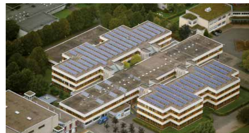
Auf vielen Schulgebäuden wie hier im Schulzentrum Königsborn arbeiten PV-Anlagen.
