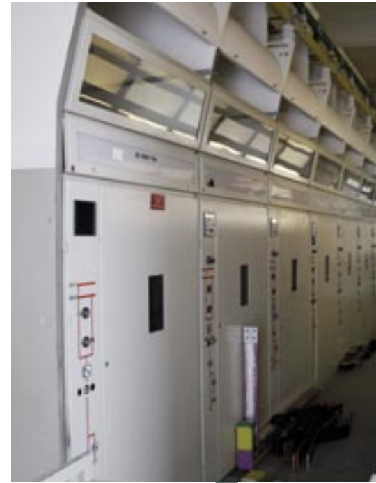
Das Umspannwerk Unna wird jetzt komplett modernisiert.
