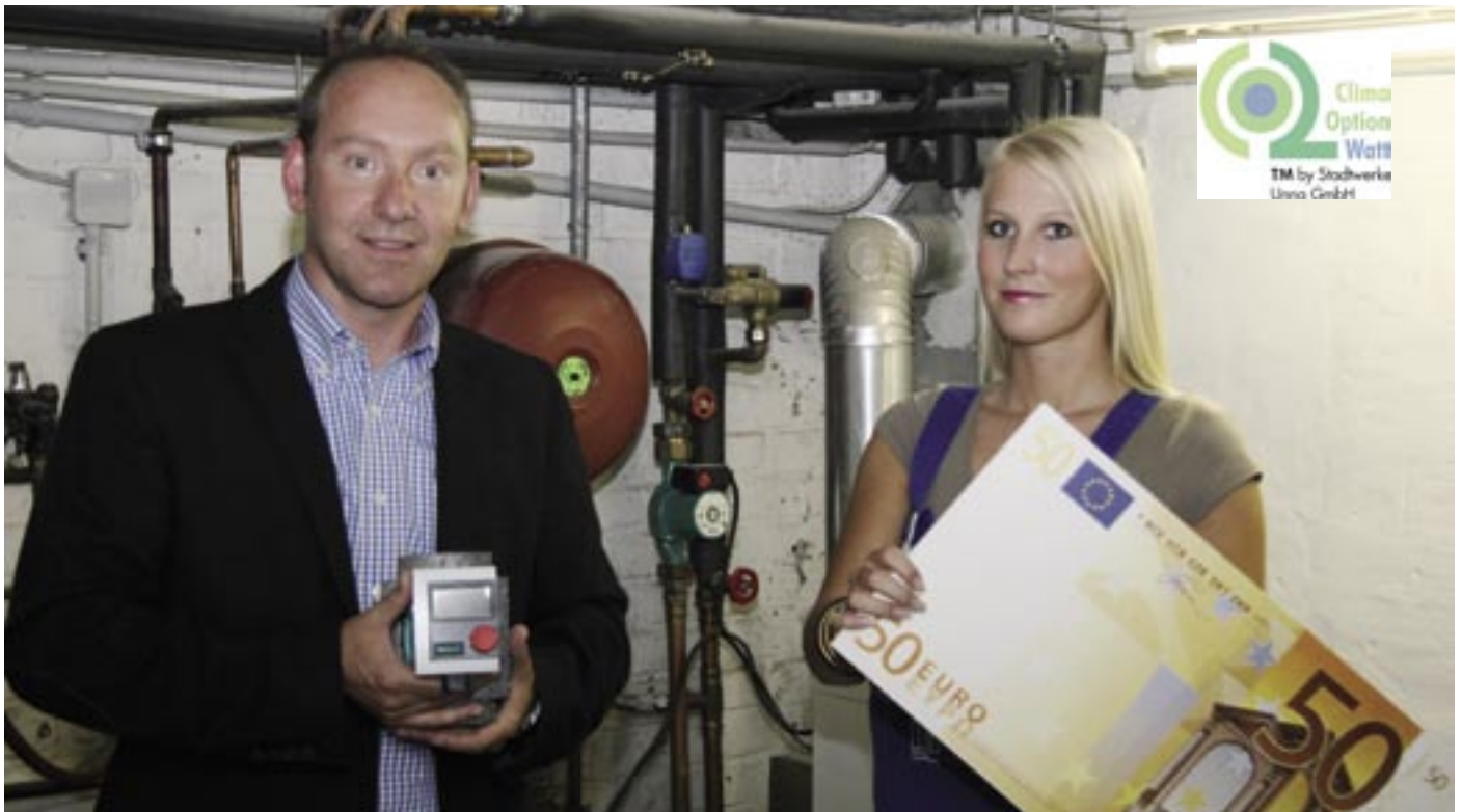
Kleiner Beitrag zur Energieeffizienz: Wir fördern mit hohem Erfolg den Austausch alter Heizungspumpen gegen moderne Effizienzpumpen.
