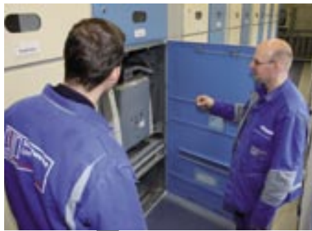
Die Arbeiten erfolgen ohne Unterbrechung der Versorgung.
