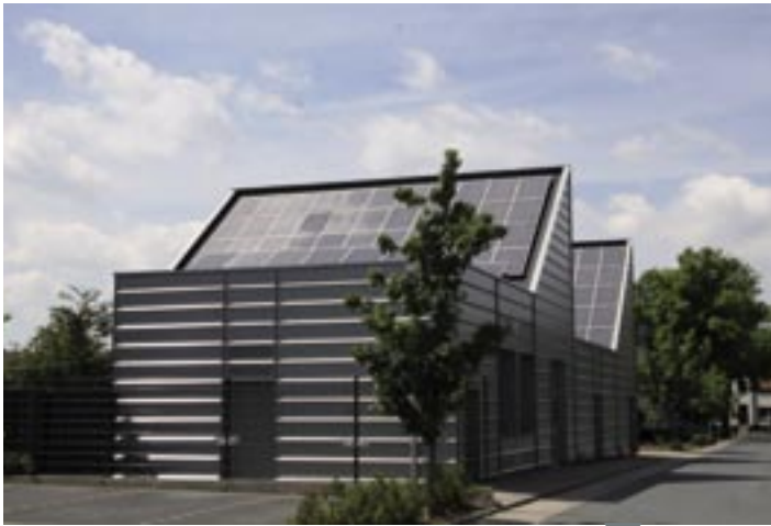
Photovoltaik-Anlage auf der Station Schlängelstraße
