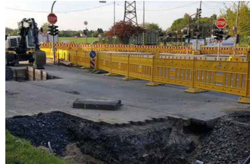
Die Umbauarbeiten für die neue Straßenkreuzung an der HansasträÙe erfordern umfangreiche Leitungsverlegungen. Wir nutzen diese für eine Optimierung unseres Netzes..
